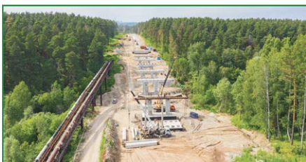
Дорога в будущее. II этап строительства
